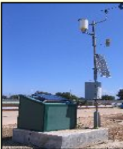
Stazione di monitoraggio meteo-climatica e di controllo della falda acquifera del comparto
